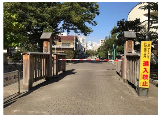
修理後のゲート
